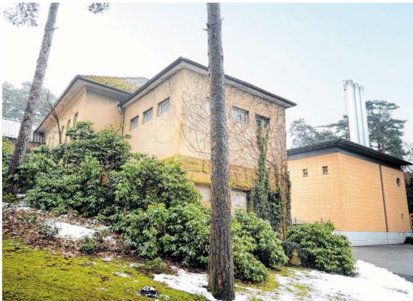
Zwei Öfen ausgefallen: Im modernen Krematorium auf dem Sennefriedhof (r.) arbeitet derzeit nur noch ein Etagen-Brennofen. Einäscherungen können daher nicht so schnell wie gewohnt durchgeführt werden. FOTOS: ANDREAS FRÜCHT
